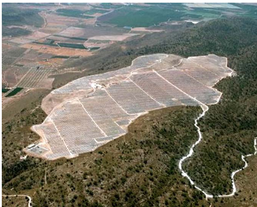
La plus grande ferme solaire du monde, à Jumilla en Espagne : 120 000 panneaux solaires pour une capacité de 20 mégawatts.
