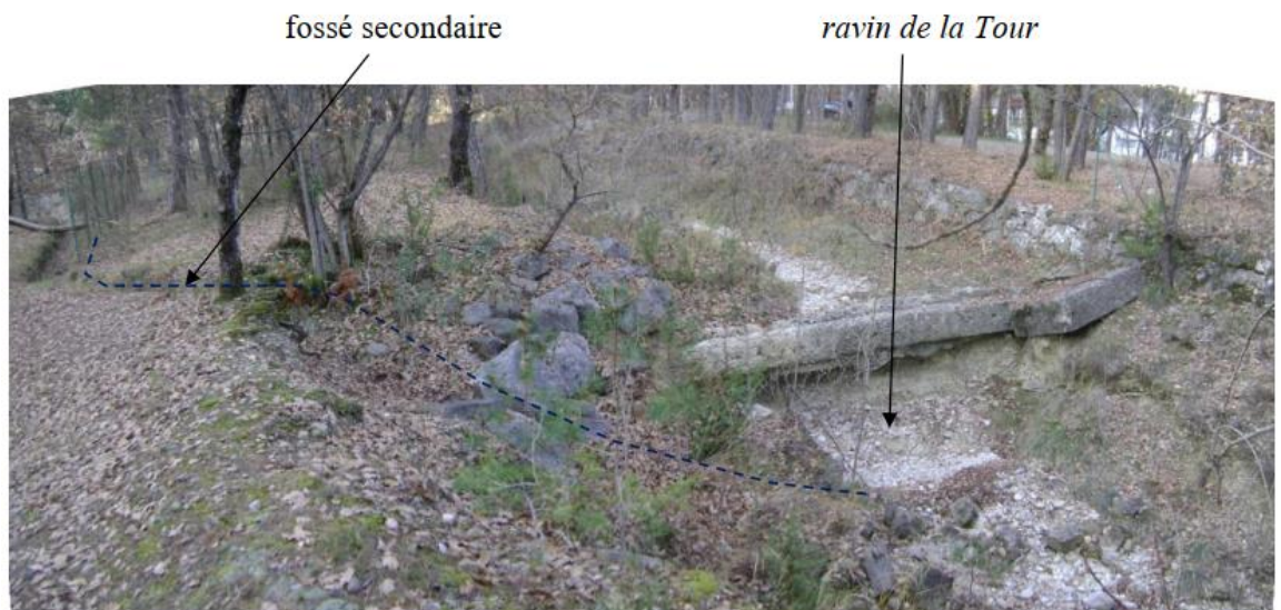
Illustration 17 : Photo de la buse de rejet des eaux pluviales de la M.A.S. dans le fossé secondaire (source : Etude sol Concept, 2021)
