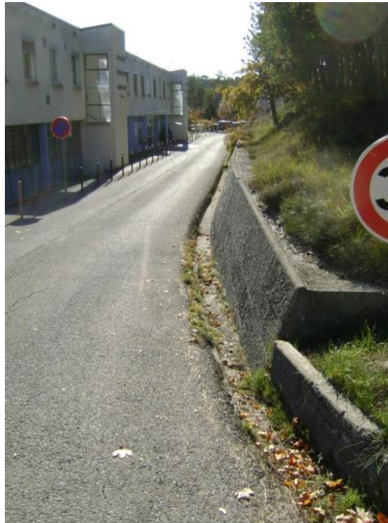
Illustration 12 : Vue de la voirie bordée par le caniveau (à droite) et le bâtiment « IFSI » à gauche (source : Etude sol Concept, 2021)
