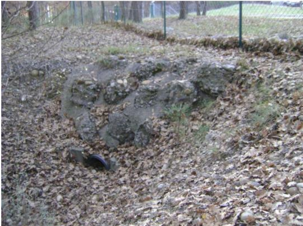
Illustration 16 : Photo de la buse de rejet des eaux pluviales de la M.A.S. dans le fossé secondaire (source : Etude sol Concept, 2021)
