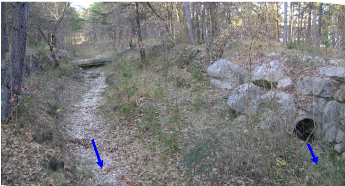
Illustration 14 : Photo du ravin de la Tour avec à droite la buse de \Phi 800 mm de sortie du réseau d'eaux pluviales (source : Etude sol Concept, 2021)
