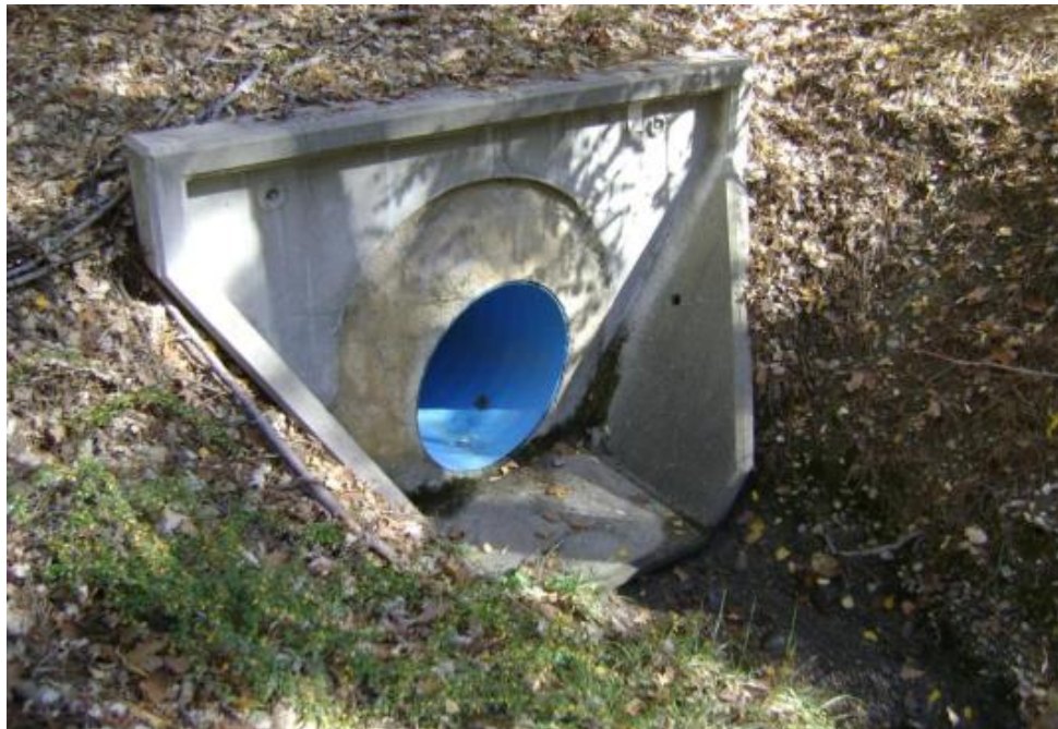
Illustration 13 : Extrémité de la buse Ø 800 mm dans le ravin de La Tour (source : Etude sol Concept, 2021)
