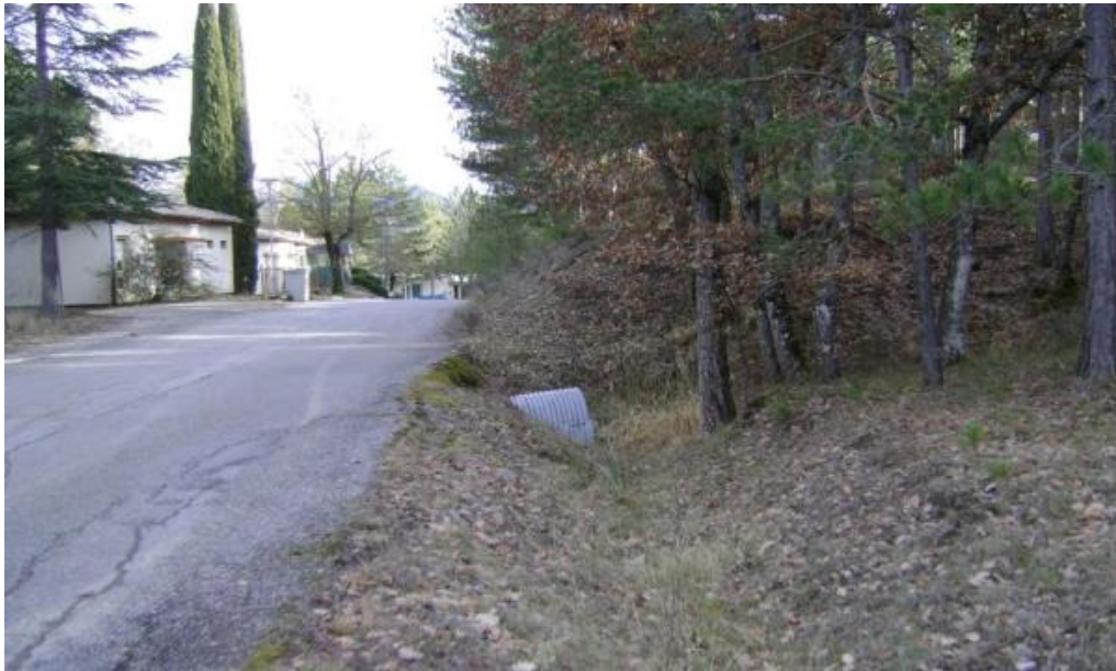
Illustration 15 : Photo de la buse passant sous la route permettant l'écoulement des eaux vers le ravin secondaire (source : Etude sol Concept, 2021)
