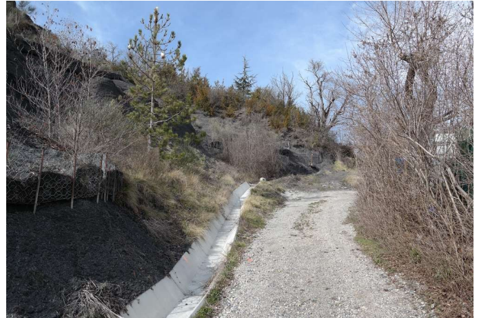
Illustration 1: Traitement de versant, et cunette d'écoulement le long du chemin de Saint-Michel.
