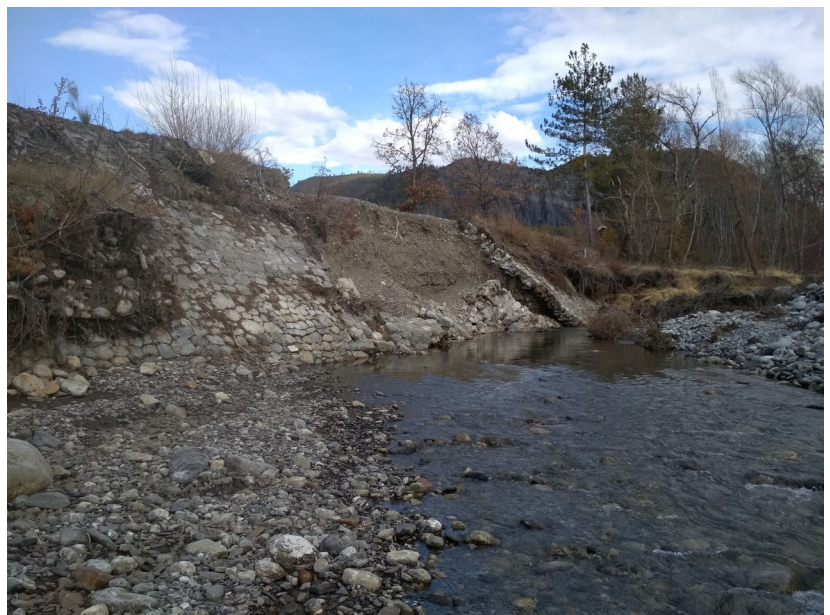
Illustration 3: Levée du Bouinenc sapée par la crue
